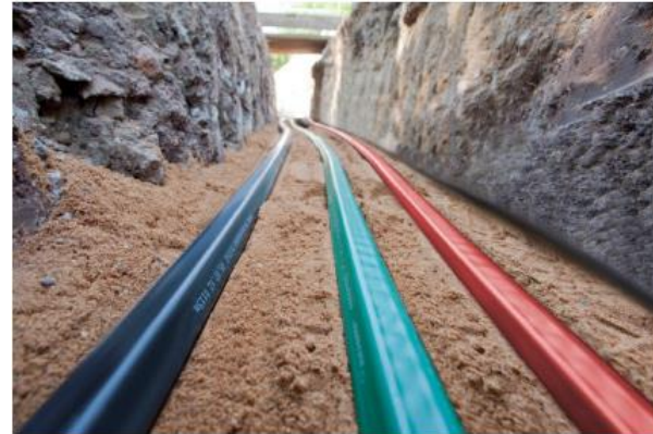
Verlegegraben (Quelle: Rehau)
