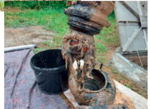
Defekte Pumpe im Gemeindegebiet, verursacht durch solche Vliestücher
