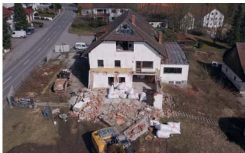
Fotos Abbruch: Hans-Martin Hilbrich
